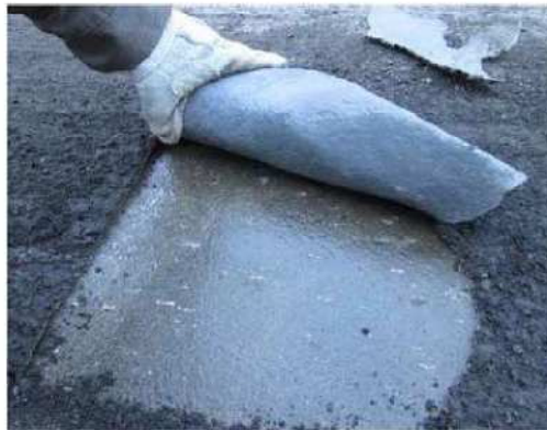
写真－2. 1 防水層の損傷事例
